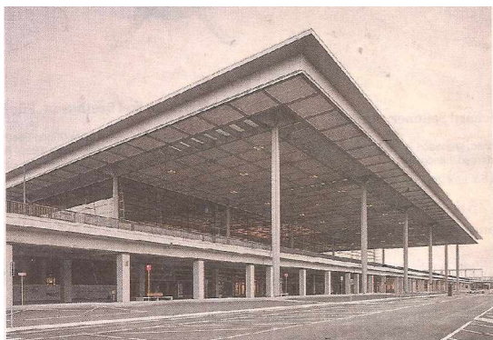
Ankunft. Das weit überkragende Dach empfängt die Berliner Passagiere großzügig auf ihrem Weg ins Flughafengebäude.
