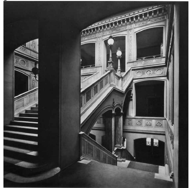
Blick ins Treppenhaus der Bauakademie im Jahr 1911: Zu erkennen sind Elemente des Stützpfilersystems mit flachen Deckengewölben. Foto: Königlich Preußische Messbildanstalt
