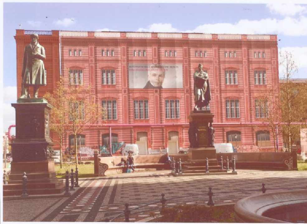
Bauakademieatraspe mit den Denkmalen von Peter Beuth (links) und Karl Friedrich Schinkel (rechts); Foto: Gisela Krehne statt des in der Berliner Zeitung veröfentlichten Fotos
