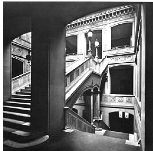
Neues Treppenhaus in der Bauakademie nach Umbau (1873/75). Foto: Meßbildanstalt 1911. In „berlin vis.à“ ist ein bearbeitetes Foto mit dem Text „ Schinkels Bauakademie: „Vernanächläßigste Architekturikone“ abgebildet.
